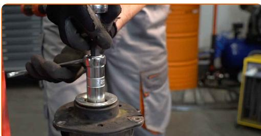
Výmena: jednotka pruženia, tlmič pruženia – VW Touran 1T1 1T2. AUTODOC odporúča:
