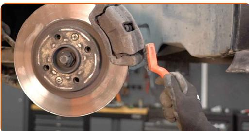
**8** Odskrutkujte upevnenie brzdového strmeňa. Použite kombinačný kľúč č.13. Použite kombinačný kľúč č.17.
